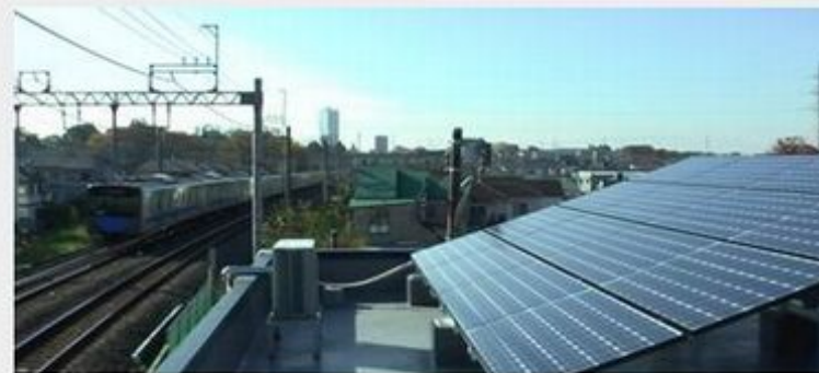
2号発電所「ふたせ」 (東村山市久米川町)
