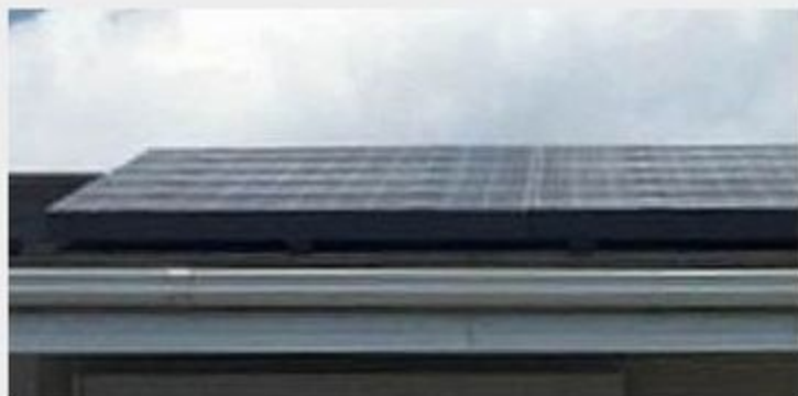
33号発電所「おいけ」 （東村山市多摩湖町）
