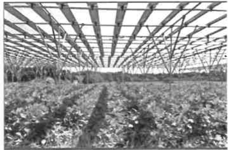
図6 ソーラーシェアリング (写真は匝瑳市)
