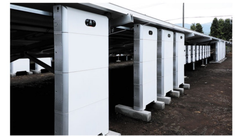
ファウエイ蓄電池は太陽光パネルの下に収まる大きさだ
